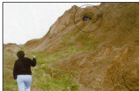
Prozkoumávání díry ve východním boku objektu. Zapáchá tam asphalt...
